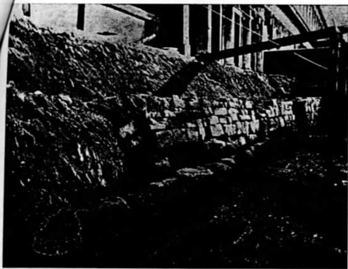
fig. 6a Veduta della fondazione abbandonata della testata nord della Panetteria, posta fra la Libreria e il Campanile di S. Marco Venezia, Museo Correr, Archivio fotografico (prov. Ufficio Tecnico Comunale) neg. varie n. 8634 (cassetta 137)
