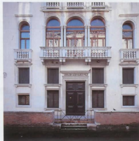
**PALAZZO BOLLANI.** L'irrobustimento dell'antica costruzione gotica è stato ottenuto con una tecnica mai sperimentata in strutture veneziane: la tensione di cavi d'acciaio entro le sottili murature. Questo restauro è il primo compiuto con la "legge speciale" per Venezia.
